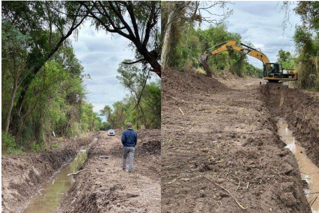
Procesos de canalización, con el propósito de abastecimiento de agua y control de excesos superficiales
