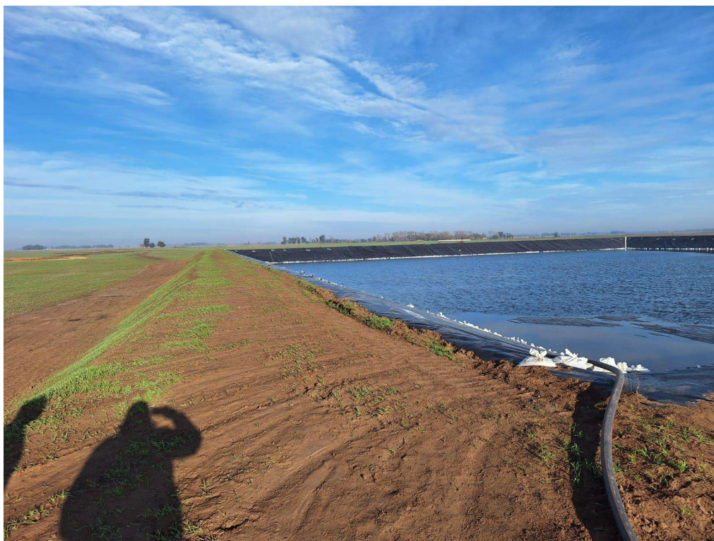
Pileta revestida en proceso de llenado
