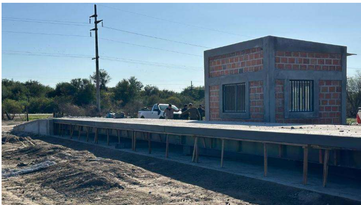
Trabajos de preparación del terreno a posterior de su limpieza de vegetación, abajo balanza
