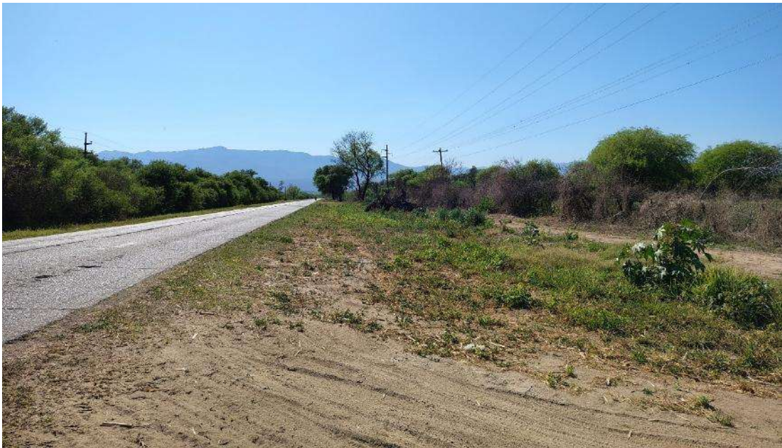
Acceso a la planta vista desde la Ruta 1
