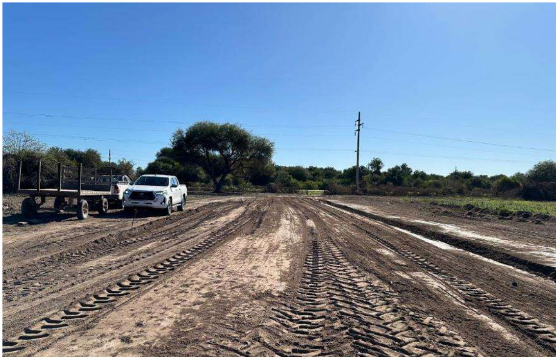
Trabajos de preparación del terreno a posterior de su limpieza de vegetación, abajo balanza
