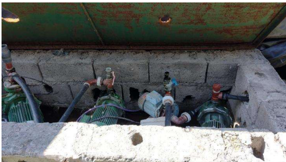
Captación y conducción del agua, hasta la zona de elevación mediante bombeo (Piletón hormigonado)
