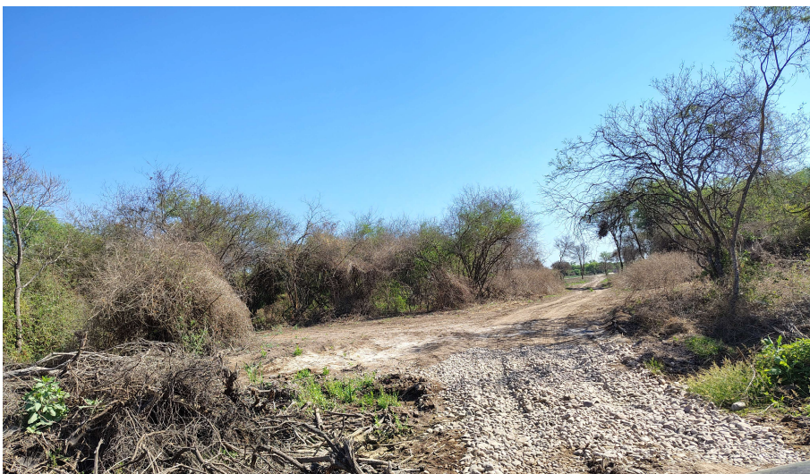
Aéreas de bajos, con obras de mejoras
